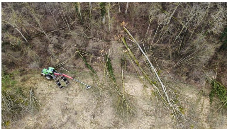
Figure 10 Traitement lisière entre Avenches et Salavaux
