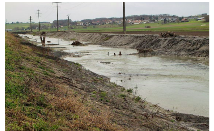
Le secteur près de Vully-les-Lacs est assaini et les digues de la Petite-Glâne sont montées. Les ensemencements et plantations se dérouleront respectivement au printemps et à l'automne prochain.
